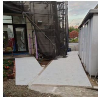
車いす用スロープを設置
